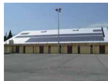
Visite à Vence du gymnase Dandrèis dont la façade sud accueille 260m 2 de panneaux photovoltaïques pour une production annuelle d'environ 20 MWh/an
