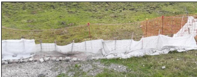
Exemple de textile filtrant mis en place pour retenir les boues
