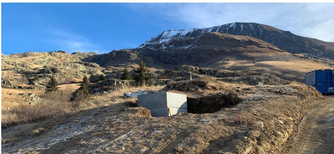
Exemple de regard en phase travaux (source : Karum : le terrain est mis à niveau par la suite
