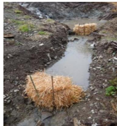
Figure 1 : Exemple d'un système de filtration mis en place lors de terrassements - source : KARUM
