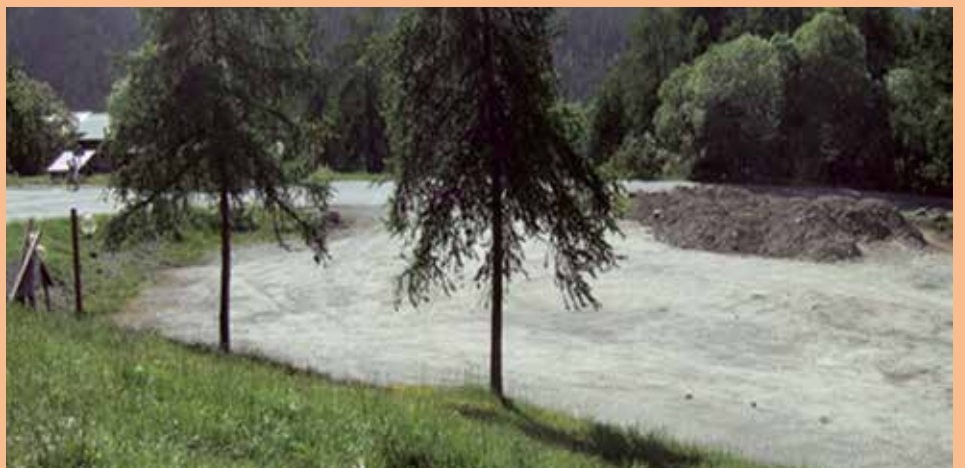
Parking de l'Estomac 1 pendant les travaux d'agrandissement.
