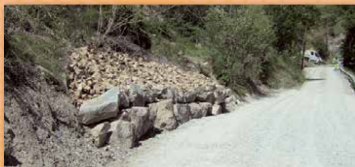
La route départementale après les travaux de drainage et avant le regoudronnage.
