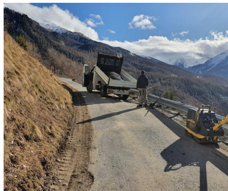
En février dernier, la route du Château a subi un affaissement au droit d'une combe, quelques centaines de mètres avant l'entrée dans le hameau. Les Services Techniques ont fait un confortement plus bas dans la combe, ainsi qu'au droit de la route, et un renforcement de la chaussée a été réalisé. Une surveillance de son évolution est assurée depuis.
