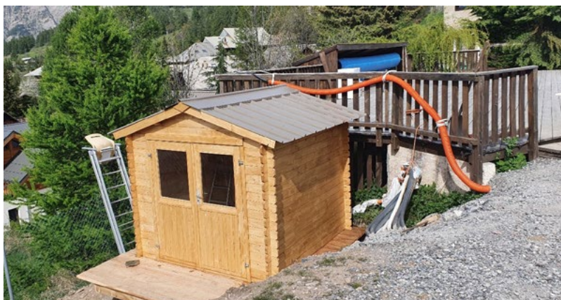
Pour améliorer l'environnement de la pataugeoire de la piscine municipale, une cabane a été fabriquée. Elle renferme les installations techniques de la pataugeoire.
