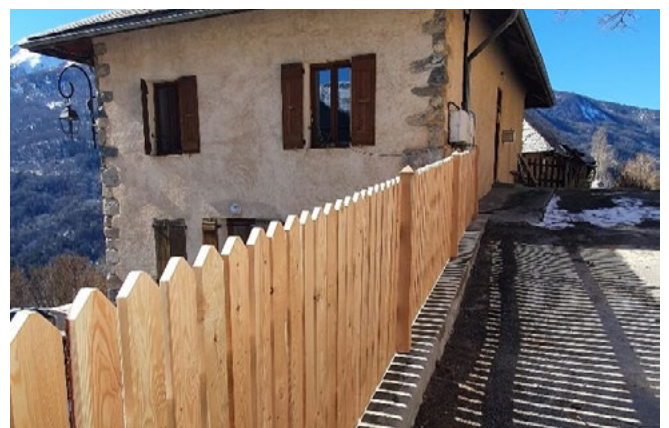
Face à l'église, la barrière le long de la Cure a également été intégralement refaite.
